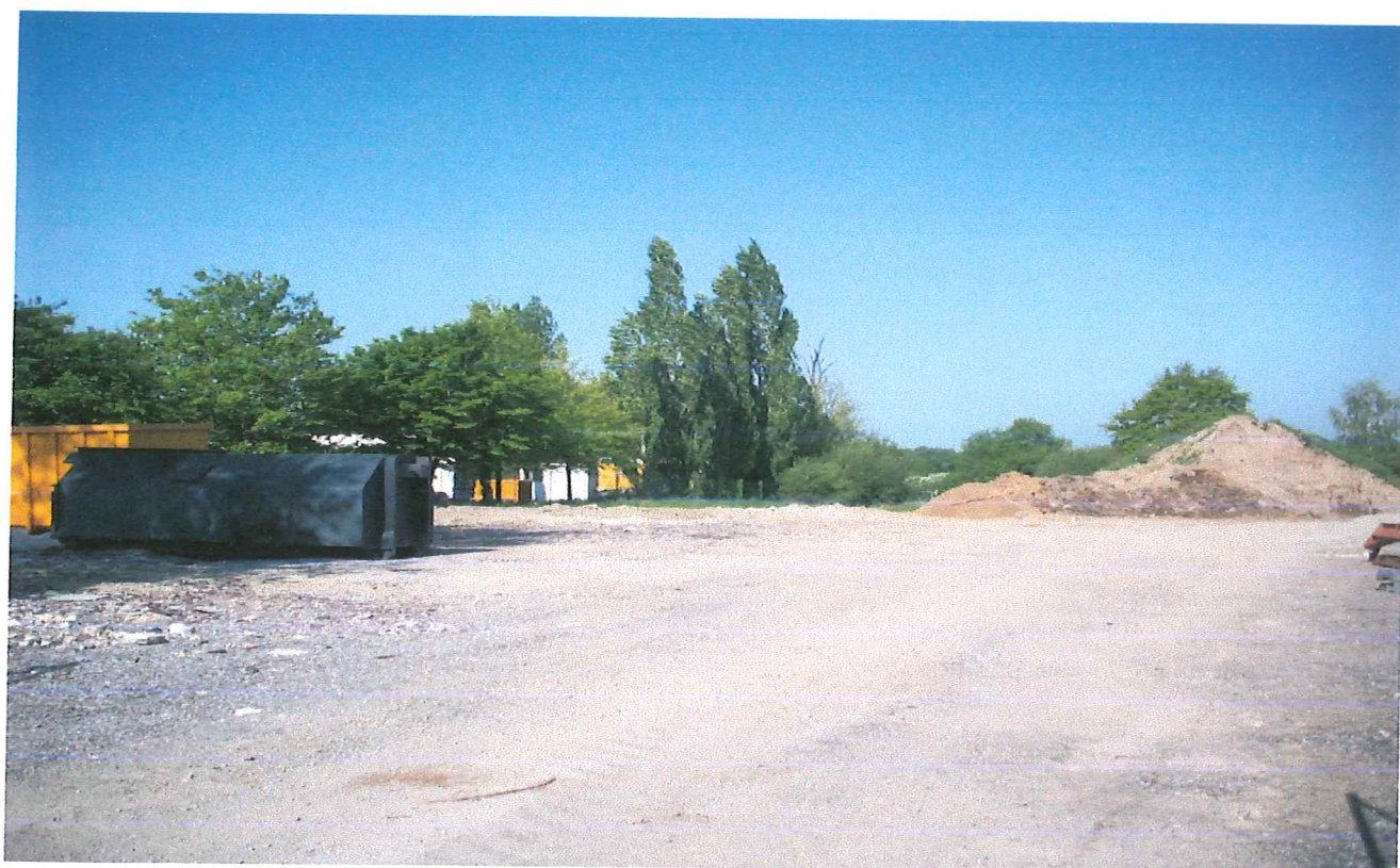
Vue nord-ouest du terrain appartenant à la société GAVANIER, en attente de travaux pour l'installation de la plateforme de transit et regroupement de déchets amiantés.
